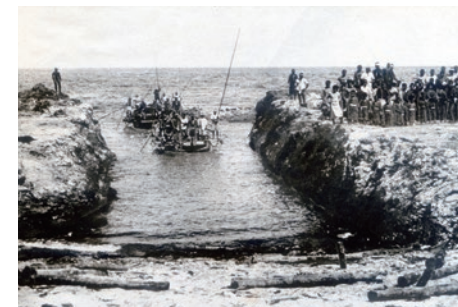
ダイナマイトで岩場を爆破して作った船着き場 撮影:1908(明治41)年ごろ
