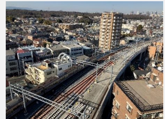
〔東村山駅付近 連続立体交差事業〕
