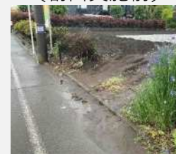
〔土留め実施前〕
