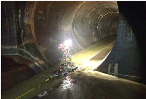
〔テレビカメラによる流域下水道幹線の調査〕
