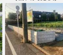
〔土留め実施後〕
