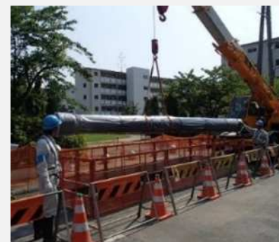
〔配水管の耐震継手化工事〕
