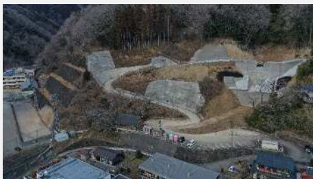
〔本宿地区第一沢 砂防堰堤（檜原村）〕
