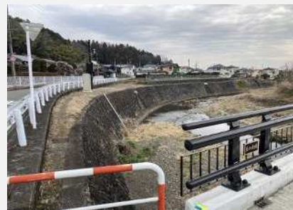
〔水位計の設置状況 (玉の内橋（平井川））〕
