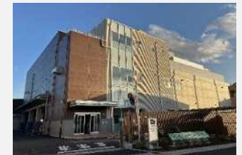
〔防災食育センター外観〕
