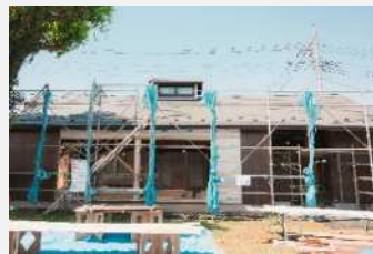
〔改装工事中の古民家〕
