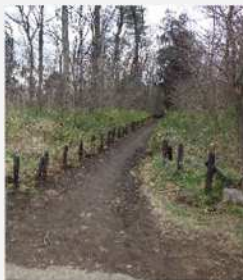
〔保護柵工事（東久留米市）〕
