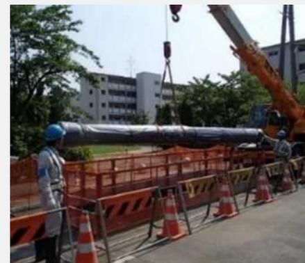
〔配水管の耐震継手化工事〕
