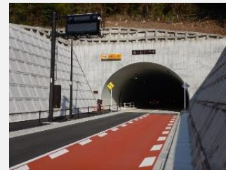
〔梅ヶ谷（うめがた）トンネル〕
