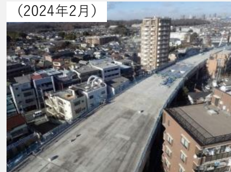
[工事中の東村山駅付近]
