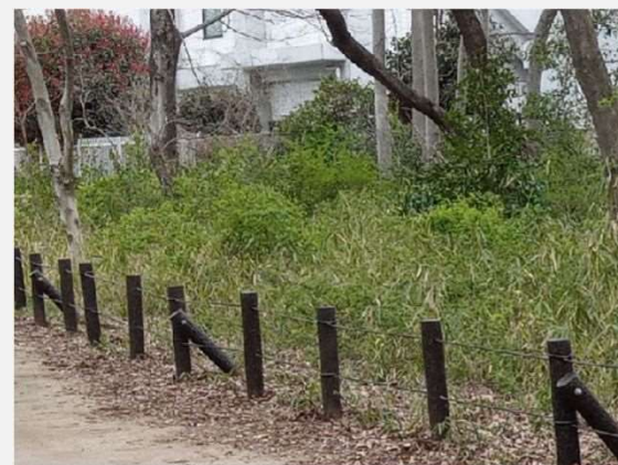
〔保護柵の設置（清瀬市）〕
