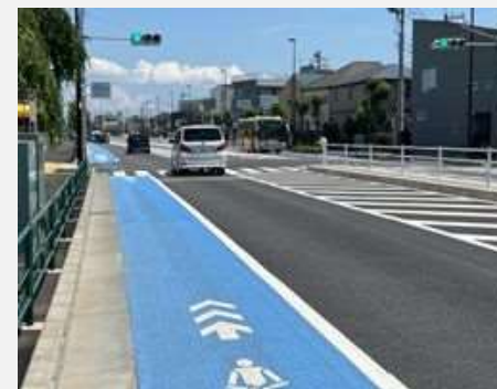
[整備後イメージ（写真は2022年度に完成した町田街道の一部）]
