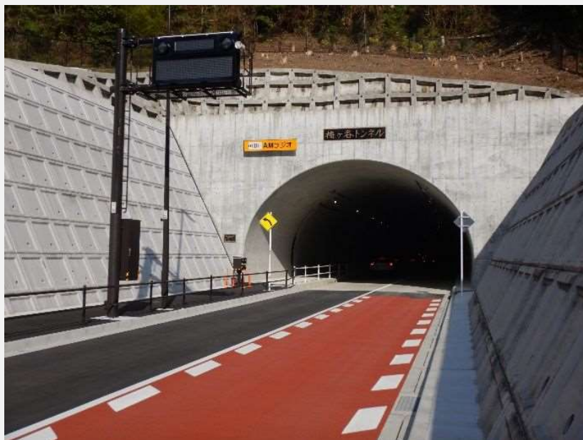
[梅ヶ谷トンネル]
