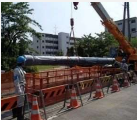
〔配水管の耐震継手化工事〕
