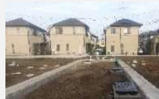
〔宅地開発無電柱化〕
