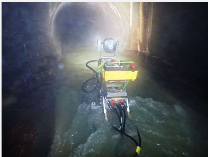
〔幹線点検作業〕
