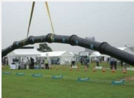
〔耐震継手管の吊り上げ実験〕
