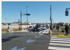
〔西東京 3・4・9 号保谷東村山線（Ⅰ期）交通開放〕
