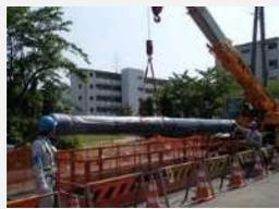
〔配水管の耐震継手化工事〕
