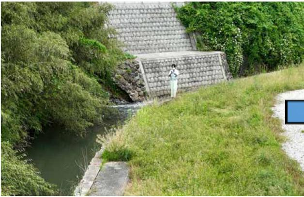
【地震により川側に傾いていた護岸】
