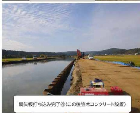
鋼矢板打ち込み完了④(この後笠木コンクリート設置)
