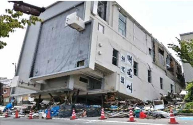
【地震で倒壊した輪島市内のビル】
