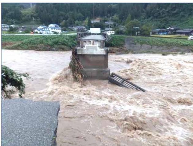
1径間が落橋した姫田橋。右岸側の橋台、上部工が流出した。
