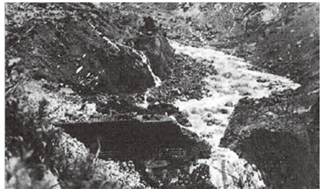
4.大正11年の豪雨災害で破壊された湯川第1号砂防堰堤（北陸地整HPより）
