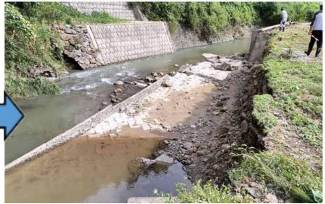
【大雨により崩落した護岸】
