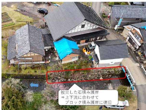
【小牧川：崩壊した石積み護岸】
