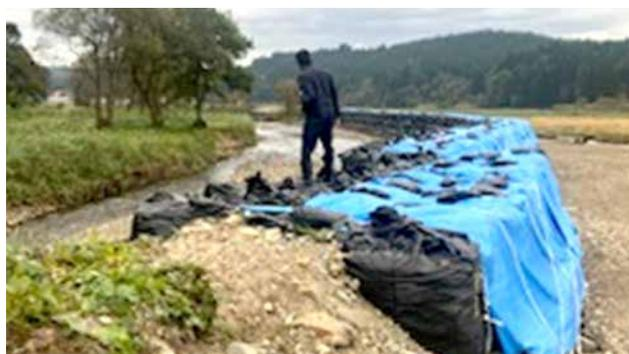
【大型土嚢で応急復旧された破堤箇所の様子（新田川にて）】
