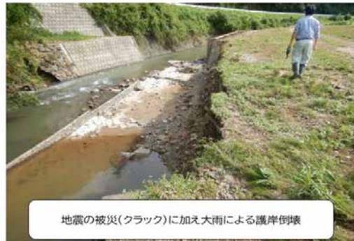
地震の被災(クラック)に加え大雨による護岸倒壊
