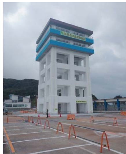
新島港津波避難施設
