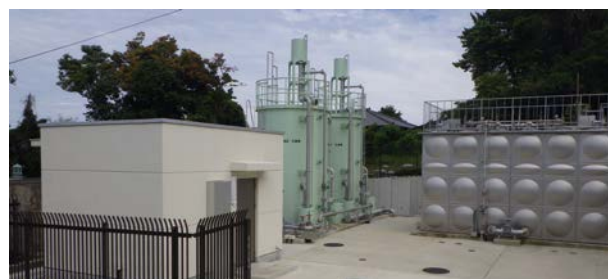
浄水場の更新事例(大島)
