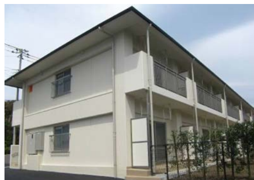
公営住宅の整備（参考例：大島町）
