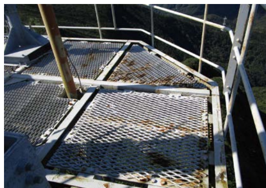
東京都防災行政無線の中継局の劣化(三原山中継所)
