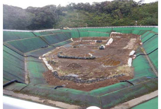
管理型最終処分場(八丈町)
