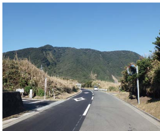
無電柱化(大島波浮港)
