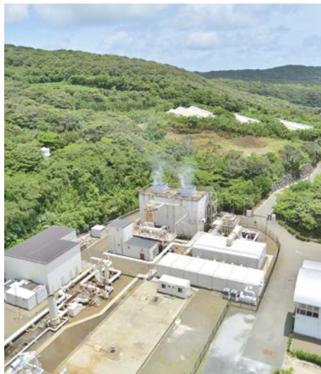
旧八丈地熱発電所
