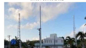
無線鉄塔(第一、第二)及び空中線用コンクリート柱
