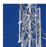
第一鉄塔上部
