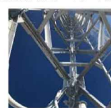
第二鉄塔内部
