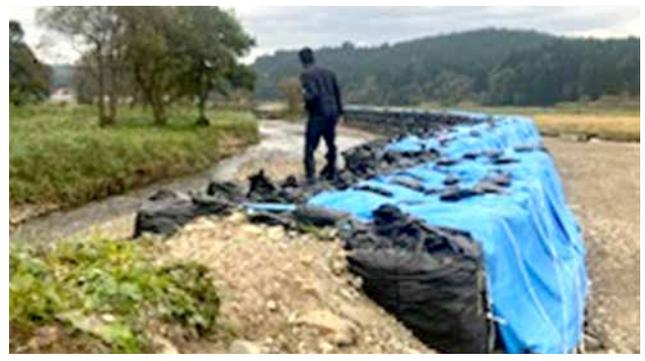
【大型土嚢で応急復旧された破堤箇所の様子（新田川にて）】
