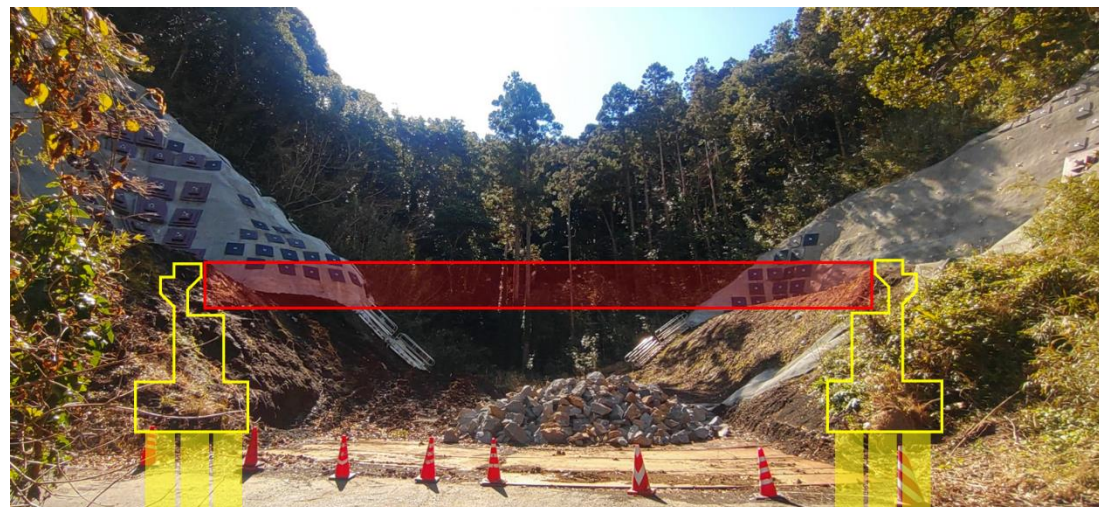
工事箇所現況（R7.3時点）と施工イメージ
