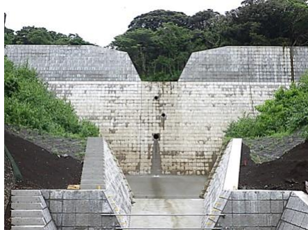
● 砂防堰堤のイメージ (筑穴ヶ沢3号堰堤)
