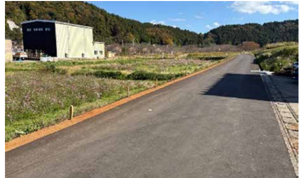
【工事完了後の現場（令和7年10月撮影）】
