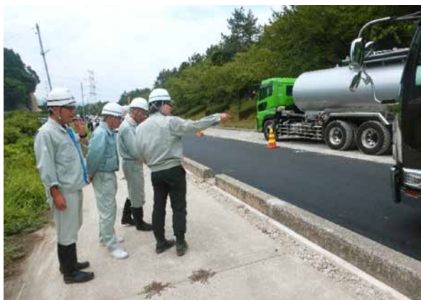
【現場の施工状況を他職員に説明】
