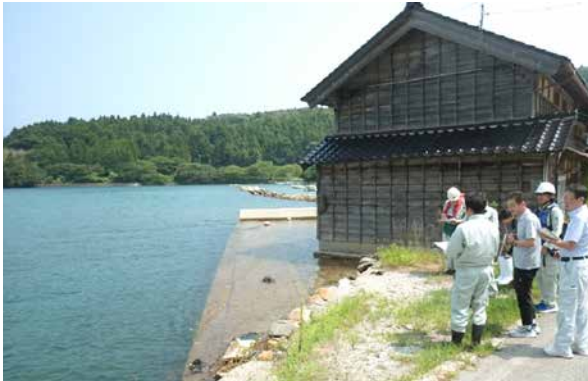
【査定官による重変箇所の確認】
