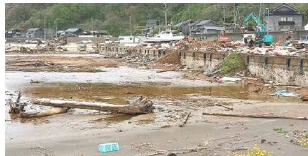
【漁港が隆起し漁船の使用ができない】
