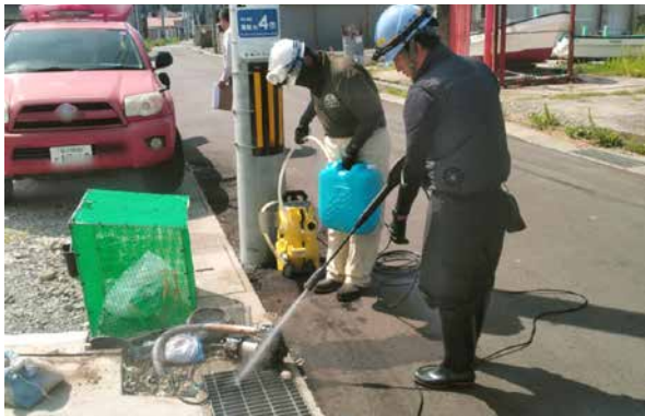
【ミニポンプ清掃作業】
