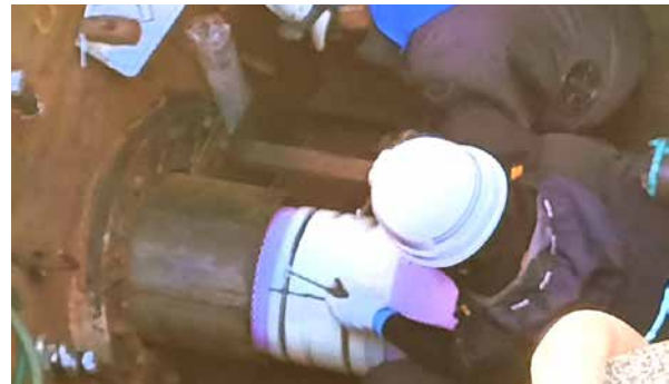
【射水市港地区】 (1本挿入したら次のMPDパイプと結束しさらに挿入していき、MPDパイプの挿入が終わったら鋼製パイプを抜き取ります。) (R7.10.15 阪井撮影)
