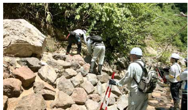
【砂防施設（流路工）の被災状況合同調査】
