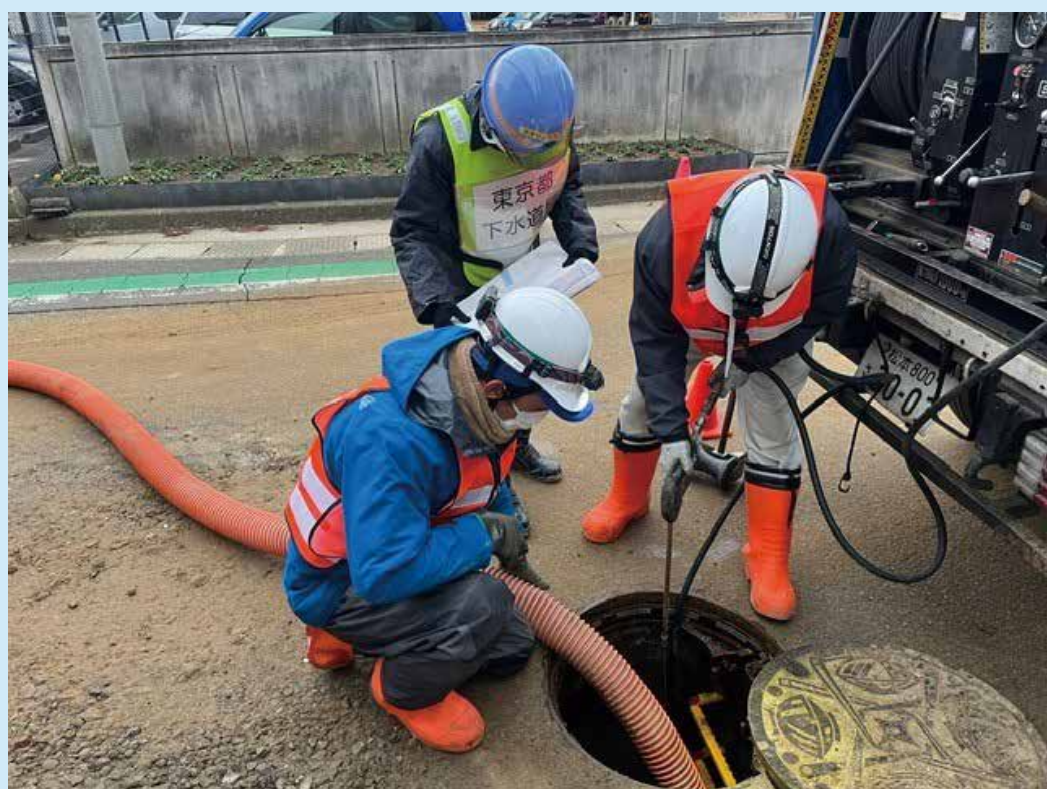
応急復旧により管内の閉塞物を除去
