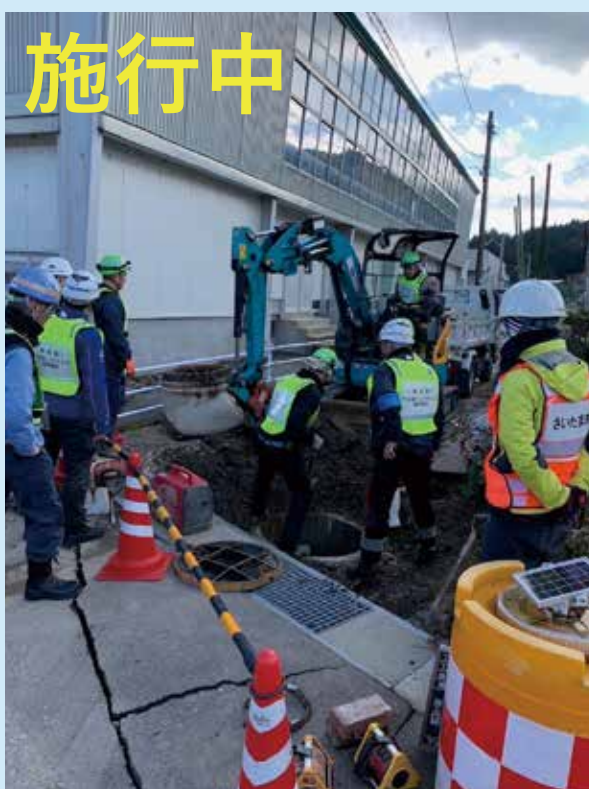
浮上したマンホールの応急復旧
