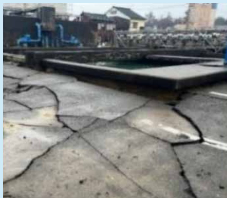
浄水場の被災状況
