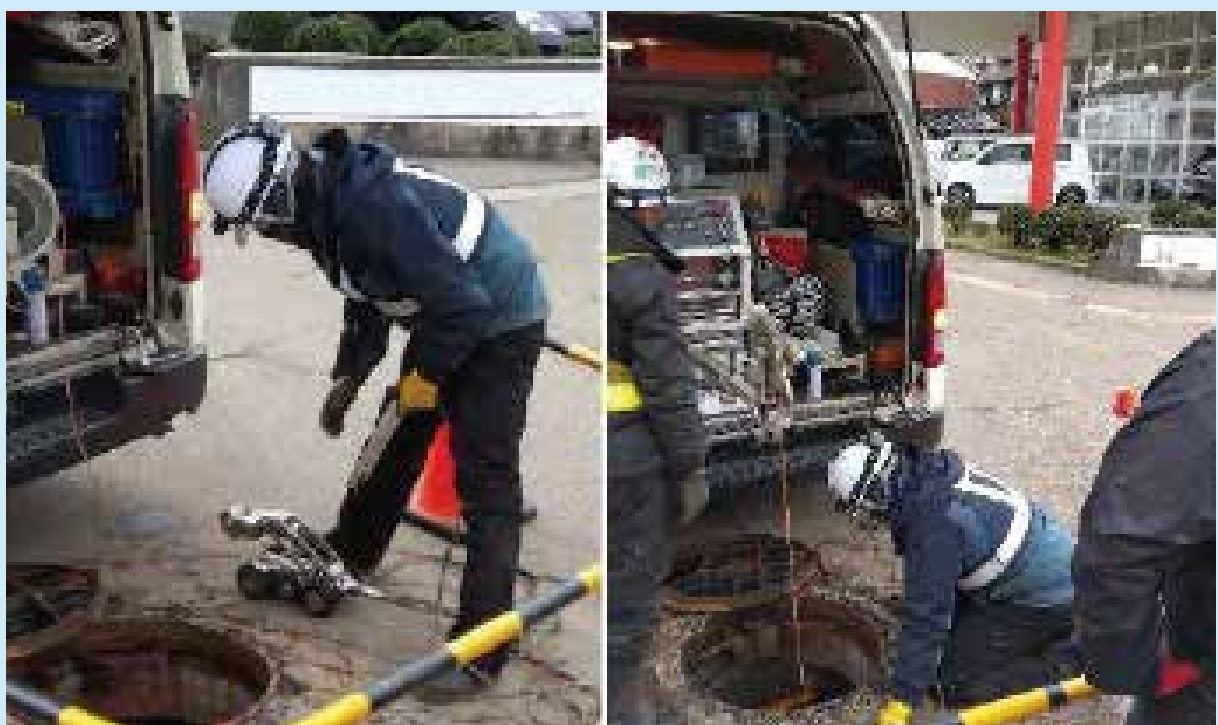
テレビカメラによる管内の確認
