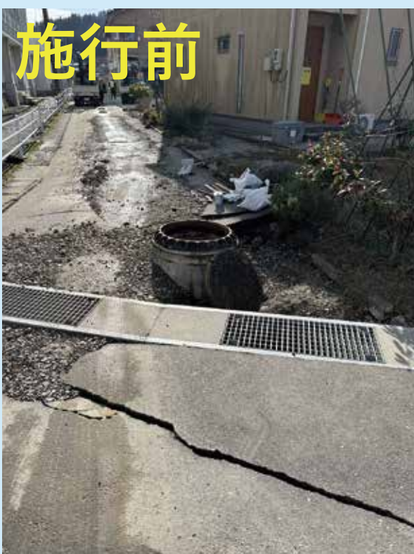
浮上したマンホールの応急復旧
