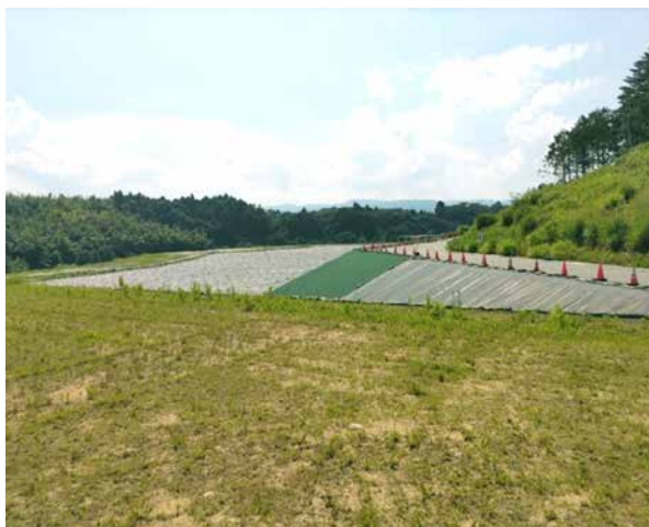
【中間貯蔵施設】
