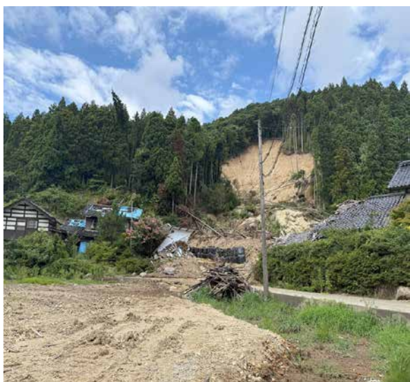
【土砂災害を受けた地域】 （令和7年4月時点）
