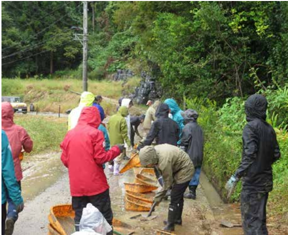
【あいにくの雨の中での泥出し作業】
