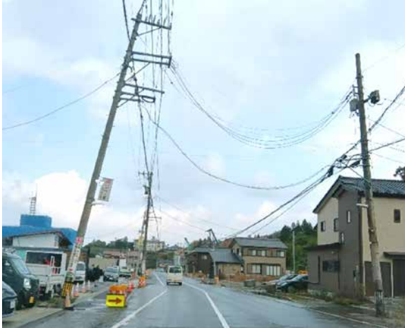
【電柱が傾いたままの状態（令和7年11月輪島市）】
