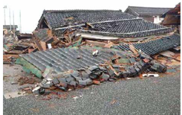
【地震により倒壊した家屋】
