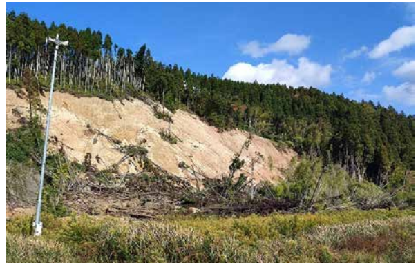
【輪島市町野地区付近（山間部土砂崩れ）】
