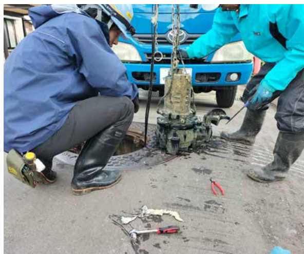
【マンホールポンプ清掃作業】
