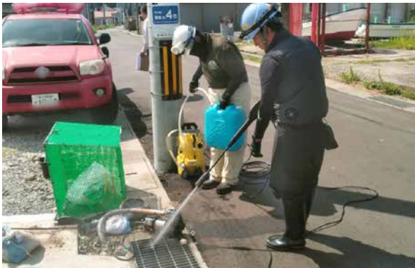
【ミニポンプ清掃作業】
