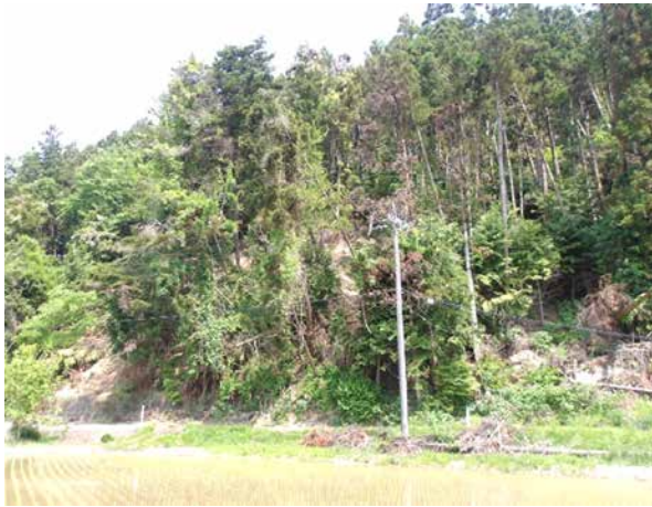
【土砂崩れ状況（遠景）】
