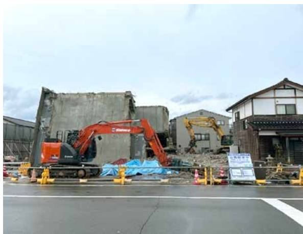
【公費解体が進められている様子（令和7年1月撮影）】
