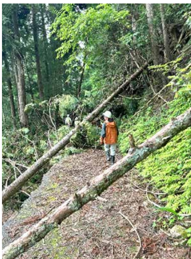
【河原田地区内市道地質調査業者との現場立ち合い状況（令和7年6月11日撮影）】 市道左谷側のり面が崩壊、右側のり面崩壊し倒木により通行不可状況
