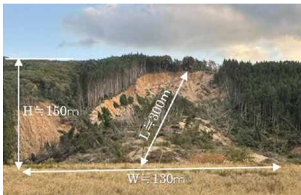
【地震による大規模崩壊】
