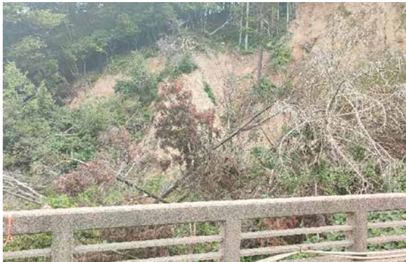
【輪島市門前地区付近（国道249号線沿）】
