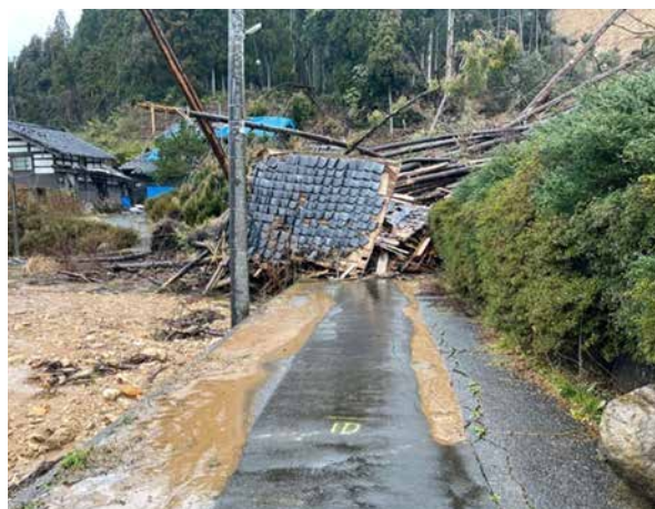
【輪島市道の様子（令和7年1月撮影）】
