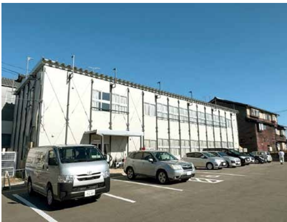
【土木課がある仮設庁舎（令和7年10月撮影）】
