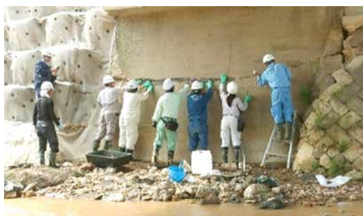
【国土交通省の指導による被災橋梁補修を派遣職員で実施】
