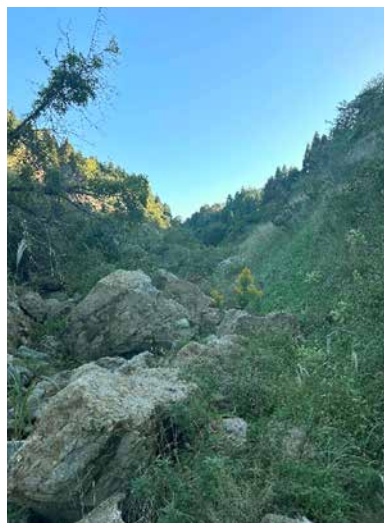
【三井地区内市道 両側のり面崩壊による通行不可箇所、現場調査（令和7年10月15日撮影）】
