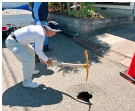
【簡易路面補修の状況】
