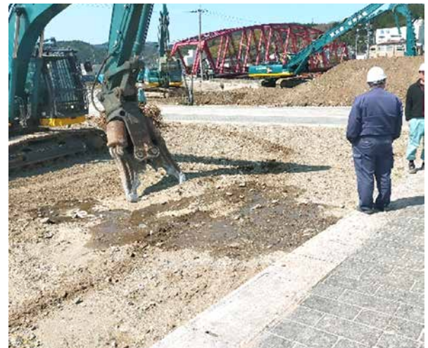
【朝市の解体現場】
