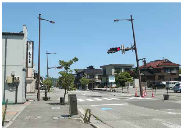
【市街地（市内中心部）電柱傾斜の様子（7月1日撮影）】
