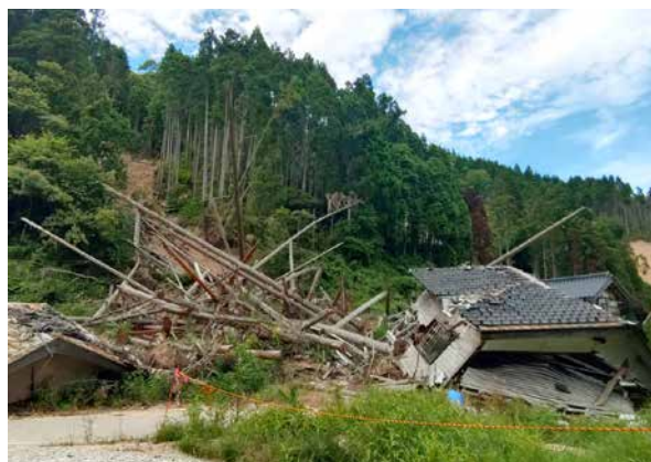
【市内土砂崩れ様子（7月15日撮影）】
