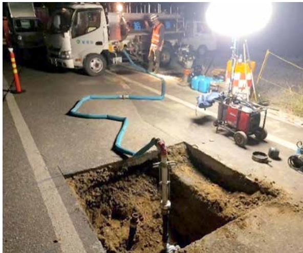
【給水車を利用したの夜間漏水調査】
