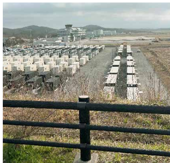
【派遣職員が居住する仮設宿泊所の全景 （令和7年4月19日撮影）】
