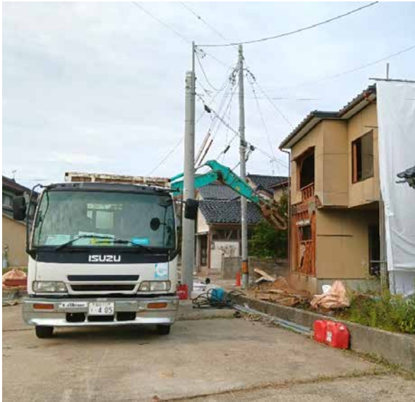
【氷見市間島・栄町地区 公費解体中の住宅】 (R7.10.07 阪井撮影)
