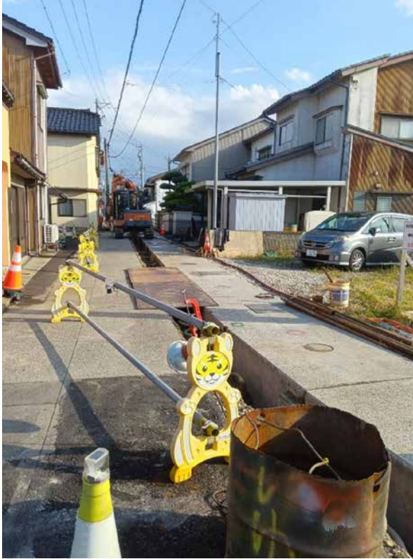
【高岡市吉久地区 下水管復旧工事】 (R7.10.27 阪井撮影)
