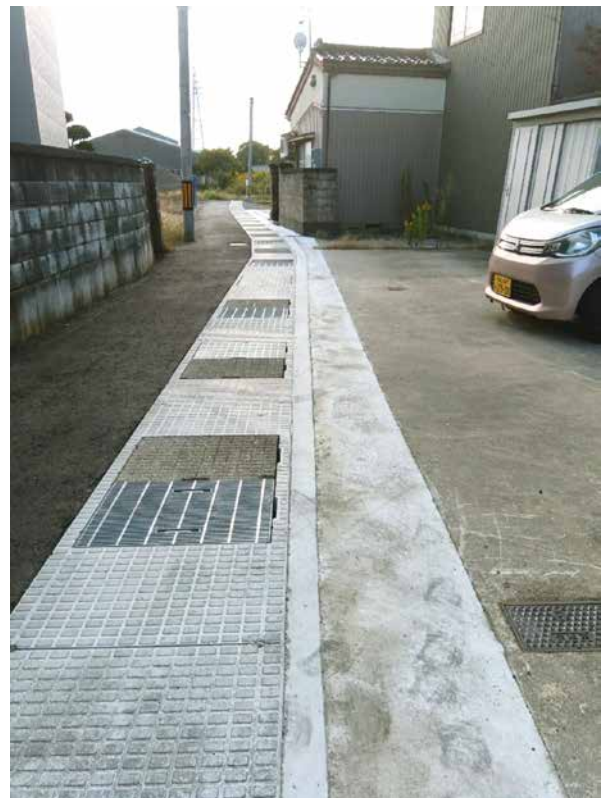
【高岡市吉久地区 側溝復旧後】 (R7.10.27 阪井撮影)
