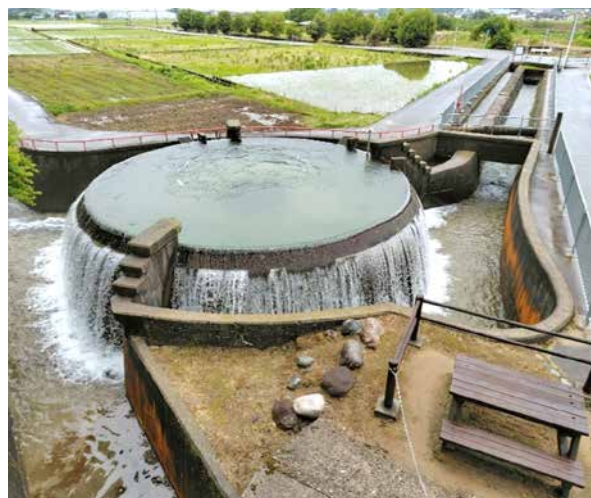
【東山円筒分水槽 (R7.6.1 石田撮影)】
