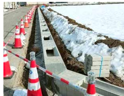
【排水溝設置工事（R7年2月）】
