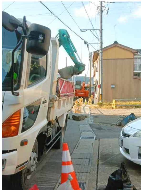
【高岡市吉久地区 奥のページの壁の家は公費解体中】 (R7.10.27 阪井撮影)
