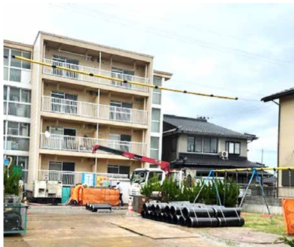
【射水市 実証実験工事現場】
