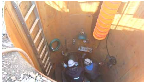
【射水市港地区】 （配管工事においては、先に鋼製のパイプが通されており、そこにMPDパイプを挿入します。） （R7.10.15 阪井撮影）
