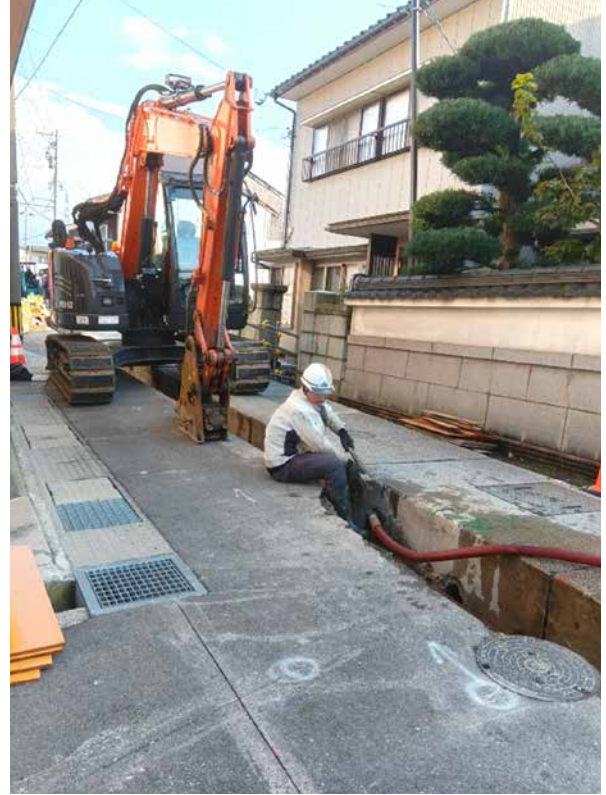
【高岡市吉久地区 下水管復旧工事】 (R7.10.27 阪井撮影)
