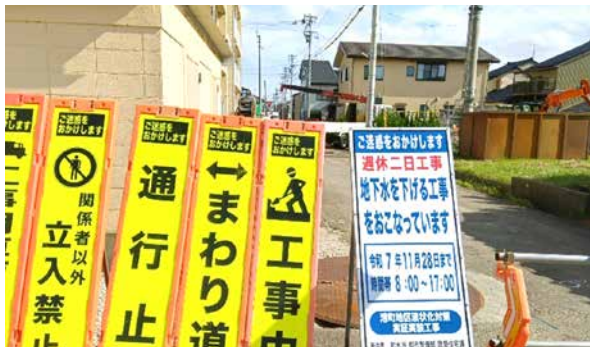
【射水市港地区】 （地下水位低下工法の実証実験の工事現場） （R7.10.15 阪井撮影）
