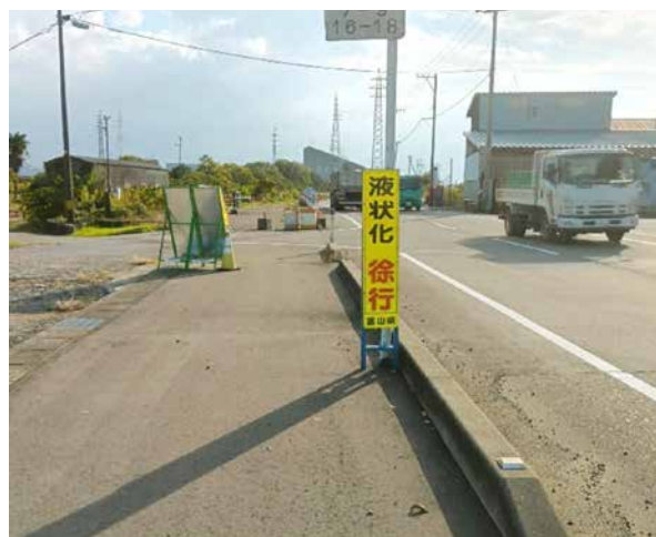
【高岡市吉久地区 液状化復旧工事現場】 (R7.10.27 阪井撮影)
