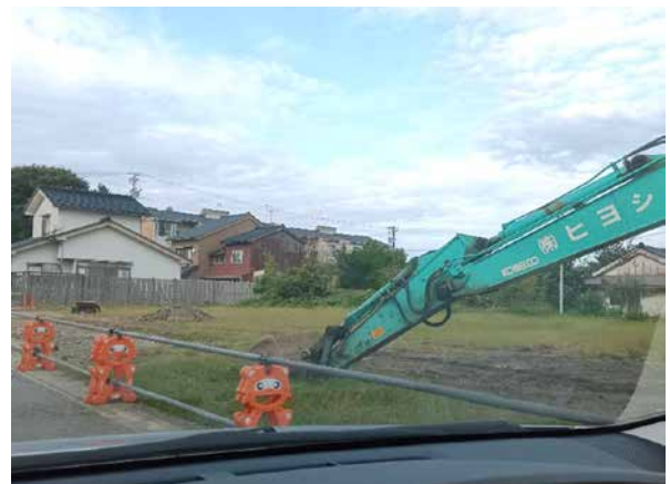
【氷見市間島・栄町地区】 （被災者公営住宅建設予定地。工事に着工したばかり。 入居予定は来年度半予定。） （R7.10.07 阪井撮影）
