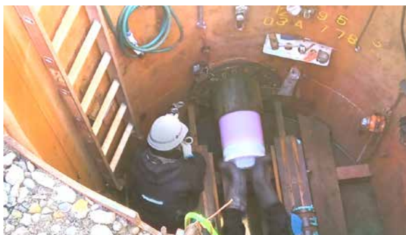
【射水市港地区】 （鋼製のパイプにMPDパイプを挿入しているところ。） （R7.10.15 阪井撮影）
