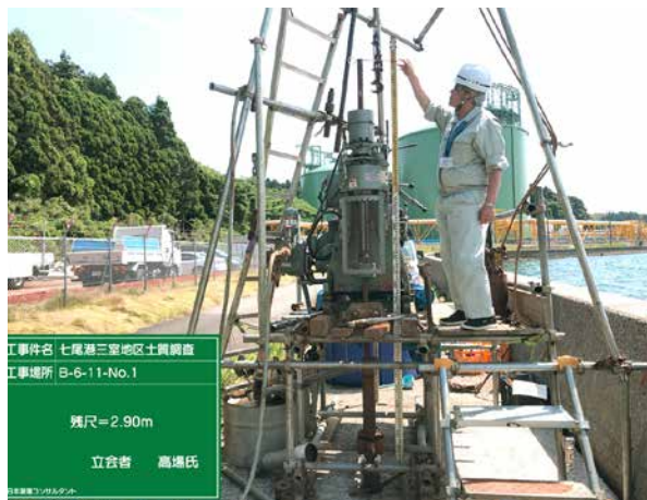
【担当する三室地区土質調査検尺立会】
