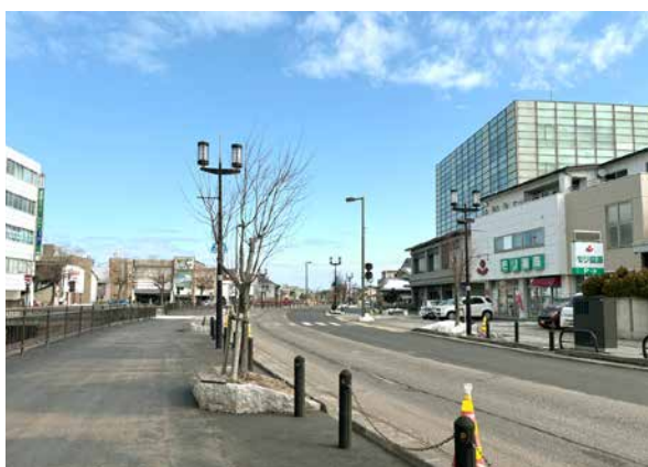
【施工後（仮復旧）】
