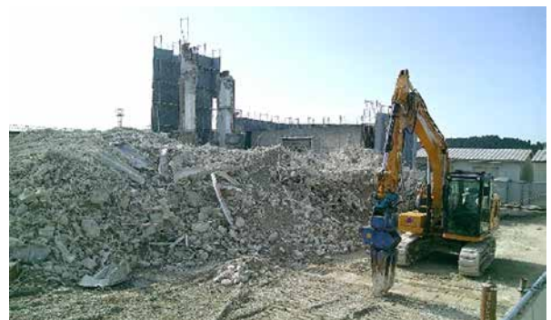
【解体中の建物】
