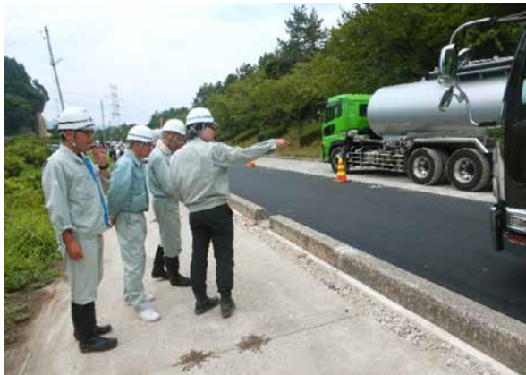
【現場の施工状況を他職員に説明】
