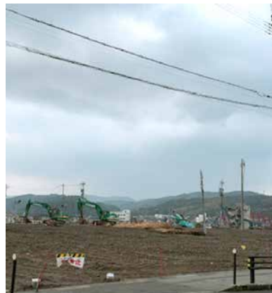
【解体が進んでいる様子@輪島朝市（令和7年1月）】
