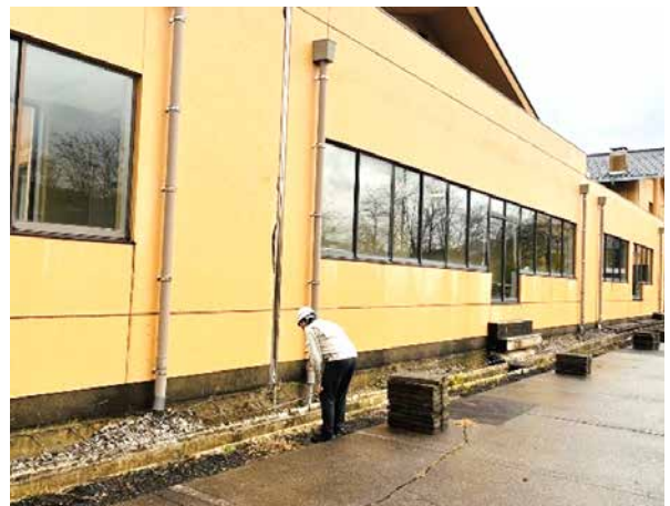
【輪島漆芸技術研修所：工事状況の確認】
