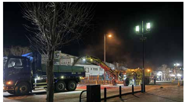
【工事施工状況】
