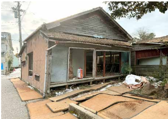
【解体が進む倒壊家屋】
