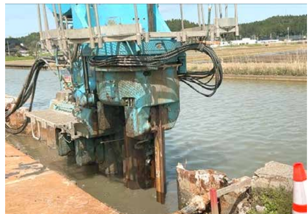
【鋼矢板(こうやいた)護岸の打設状況】
