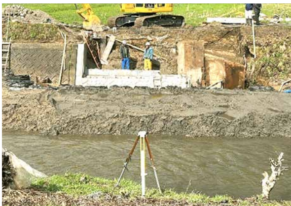
【ブロック護岸の施工状況】
