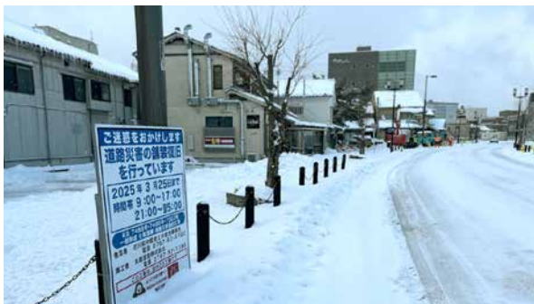
【工事現場状況】
