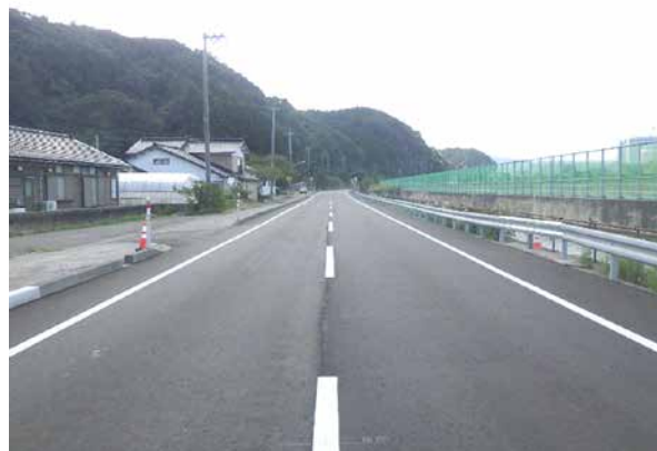
【横断水路部に段差が無くなるよう勾配を検討しながら舗装の補修を行った R7.10】
