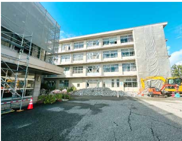
【飯田高校：外壁クラック補修状況（令和7年9月5日撮影）】
