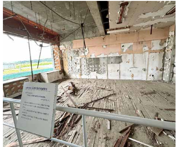
【震災遺構 浪江町立請戸小学校】
