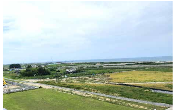
【加速化交付金を活用して整備中の復興祈念公園】
