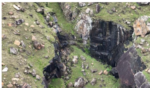
崖壁に沿う水溝（雨裂）
