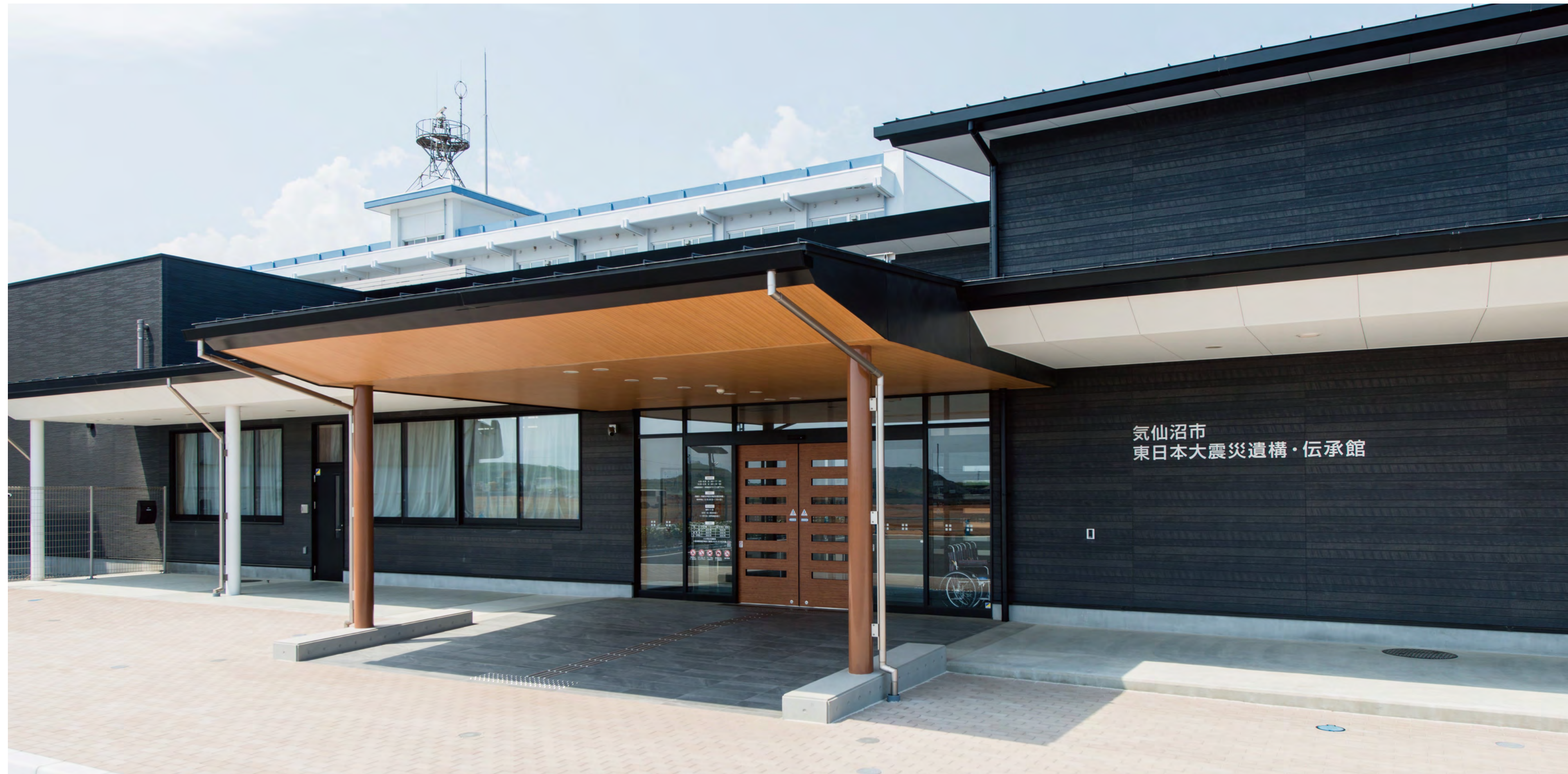
東日本大震災遺構・伝承館 外観
