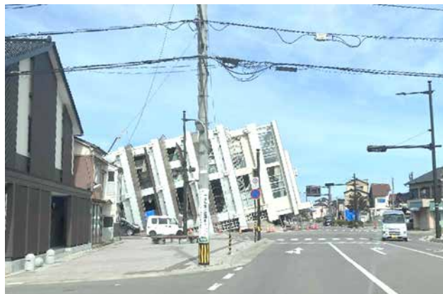
【横転した7階建ビル】
