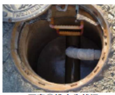
写真④ 排水先状況 （排水先は起点人孔）
