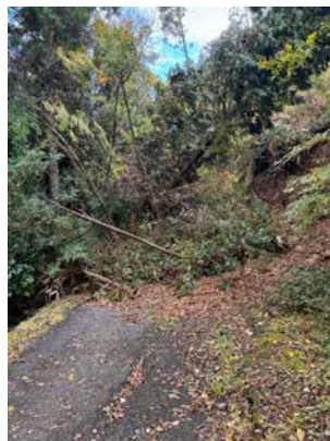
【増破による被害状況】
