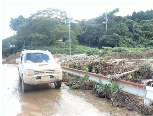
【被災直後の現場調査の様子】
