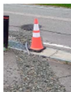
写真③ 排水状況 （排水ホースは洗濯機用）
