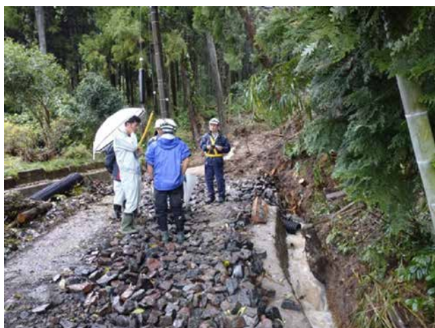
土砂崩壊現場で道路管理者と現地立会い
