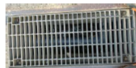
写真⑤ 側溝への仮設配管状況
