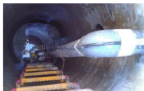
写真③ 仮ポンプ設置状況
