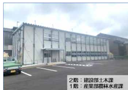
【豪雨災害時トイレが使用不可となった仮設庁舎】
