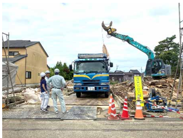
公費解体の状況（氷見市栄町新道地区）
