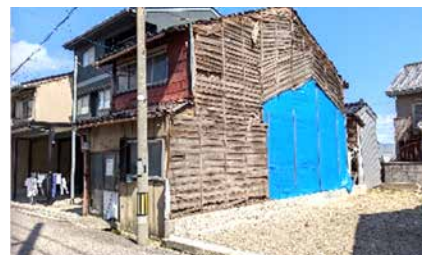
11.射水市港町地区公費解体状況
