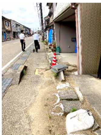
液状化による被害の状況 （左：氷見市栄町新道地区、右：高岡市吉久地区）
