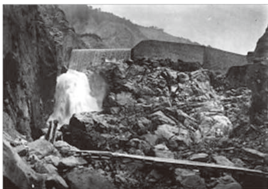
3.大正8年富山県により建設された湯川第1号砂防堰堤（北陸地整HPより）
