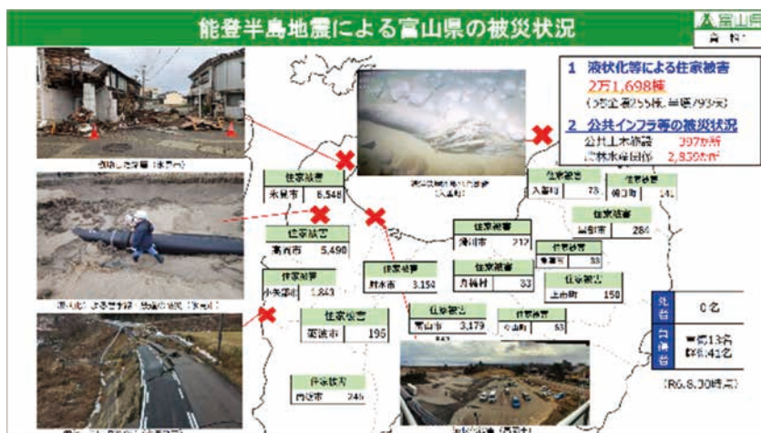
5.能登半島地震による富山県の被災状況 (令和6年度能登半島地震富山県復旧・復興本部員会議資料抜粋)
