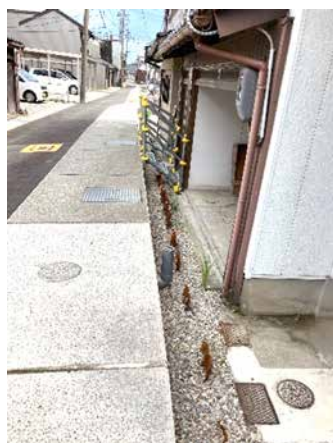
液状化による被害の状況 （左：氷見市栄町新道地区、右：高岡市吉久地区）
