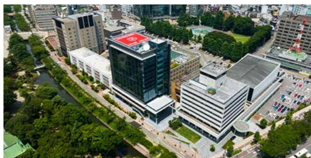
富山県防災危機管理センター （中央黒い建物）（富山県HPより抜粋）
