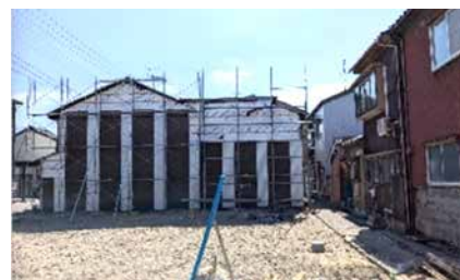
10.射水市港町地区公費解体状況
