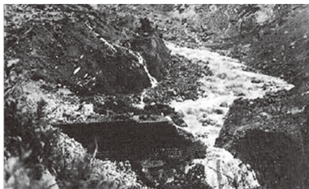
4.大正11年の豪雨災害で破壊された湯川第1号砂防堰堤（北陸地整HPより）
