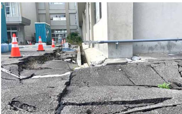
地盤沈下により損傷した外構（飯田高校）
