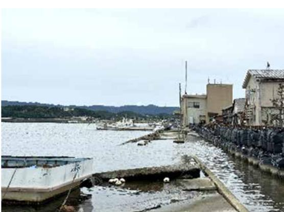
石崎漁港：沈下により施設が一部水没
