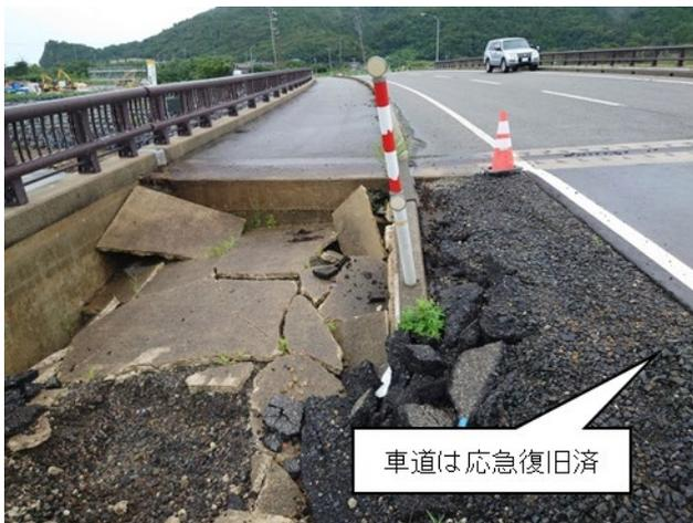
【橋梁の被災状況（前後の道路が沈下）】
