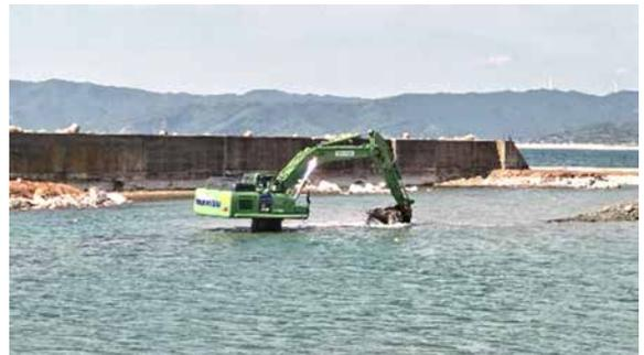
赤神漁港：応急工事（隆起した海底の掘削）
