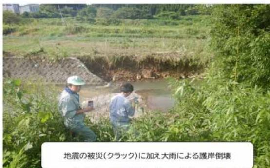
地震の被災(クラック)に加え大雨による護岸倒壊
