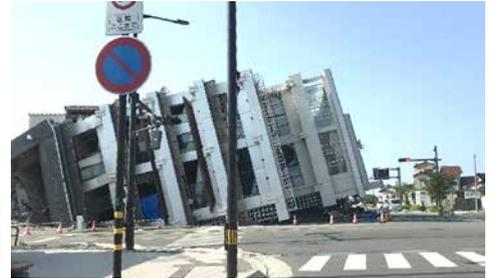
写真2 輪島の倒壊したビル
