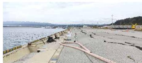
蛸島漁港：岸壁が倒壊し陸揚げ不可の状況
