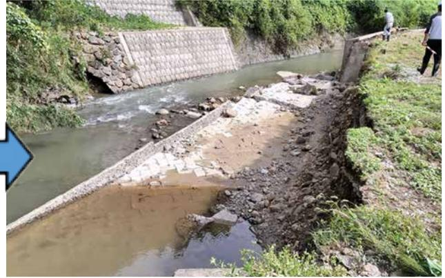
【大雨により崩落した護岸】
