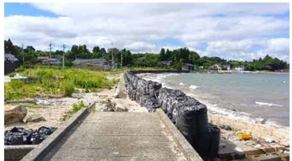
白丸漁港：津波で倒壊した護岸を大型土で仮復旧
