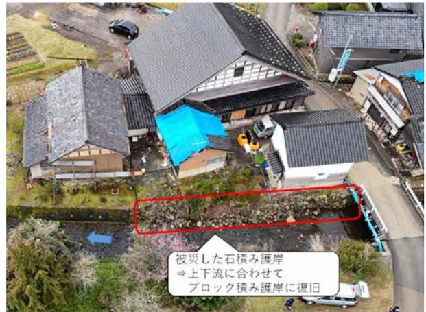
【小牧川：崩壊した石積み護岸】
