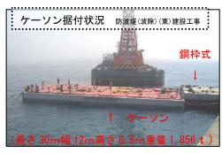
ジェットホイル高速船や漁船等が安全に接岸できるように、東側に新たな防波堤(波除)の建設に今年度より着手し、今年の7/27にケーソン1函の据付けも無事完了しました。
