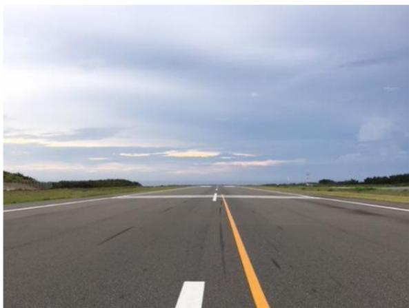
滑走路は、雨水を良好に排水するため、滑走路中心線を最も高くした左右対称に勾配を設定することとされています。神津島空港の滑走路は、横断勾配2.0%の範囲内で設定されています。
