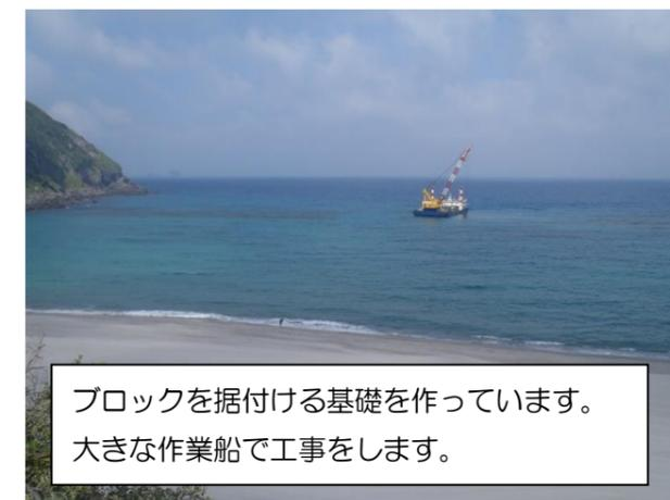
ブロックを据付ける基礎を作っています。大きな作業船で工事をします。
