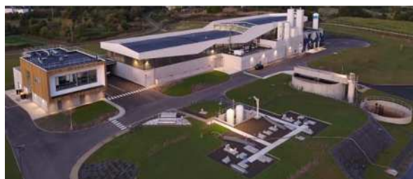
クロワ・シュラン浄水場の全景
