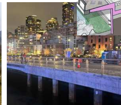
（シアトル：改修後防潮堤）
