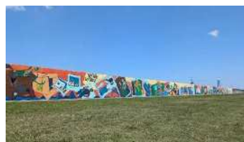
▲復旧した防潮堤
