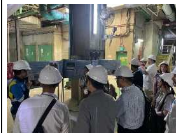
（写真1） チャンギ水再生プラント
