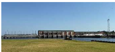
▲新設したポンプ所
