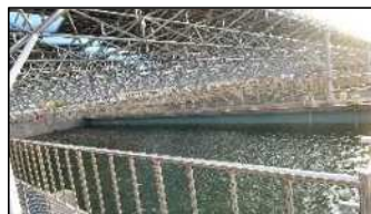
華城 A | 浄水場沈殿池
