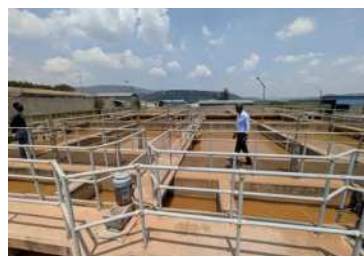
ノトラ浄水場
