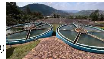
キミサガラ浄水場
