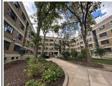
PACTによって改修された 公営住宅
