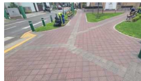
誘導用ブロックの設置状況
