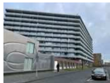
建替え修繕・活用している高層棟
