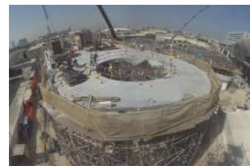
建設中のVP（正面）
