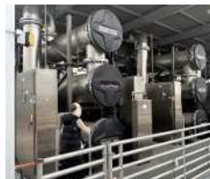
紫外線促進酸化反応装置
