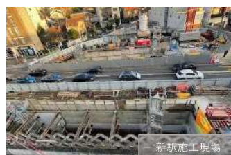
新駅施工現場
