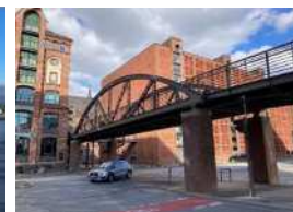
洪水時に緊急車両が通行可能な橋梁
