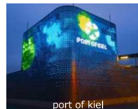
port of kiel 陸電電気設備建屋
