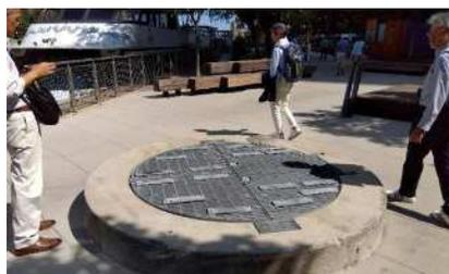
洪水時に下水を流すトンネルへの流下用縦穴
