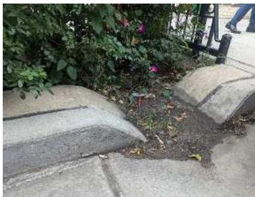
雨水導入部に土が堆積した状況
