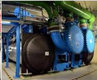
セーヌ川や地下水の水温を活用した地域冷却システム。エアコンに代わる手段として2042年までに市全域での導入を目指している
