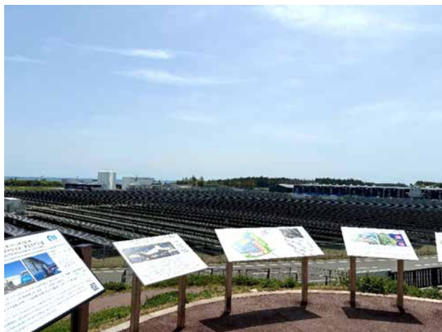
棚塩産業団地見晴台からの景色。一面の太陽光パネルとFH2R（写真左奥の白い建物のあたり）。
