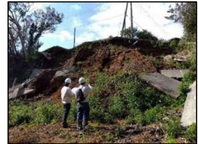
▲都技術職員による現場視察
