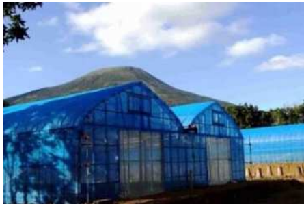
▲耐風強化型パイプハウス
