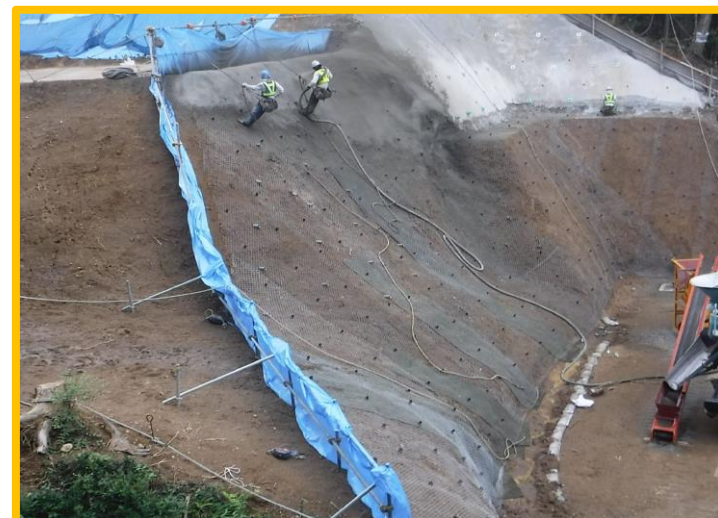
施工時の様子
