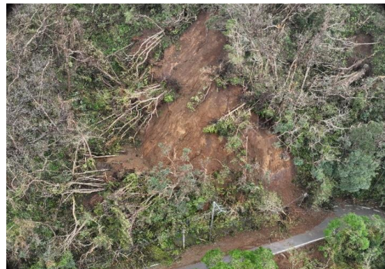
斜面崩壊(さらなる崩壊の恐れあり)
