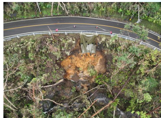
斜面崩壊(道路崩壊の恐れあり)
