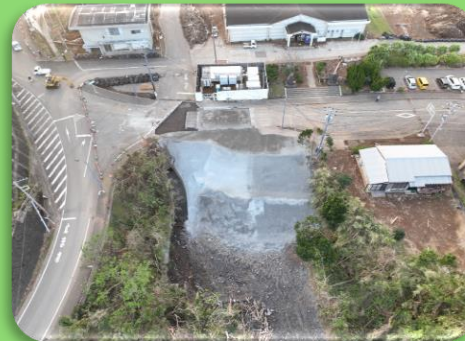
▲モルタル作業終了時のようす
