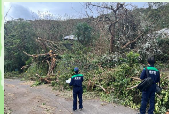
▲青ヶ島の被害状況を確認する現地調査を実施
