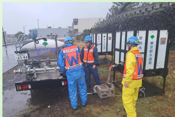
▲給水車が島内を巡回し、仮設給水槽へ水を補給する様子
