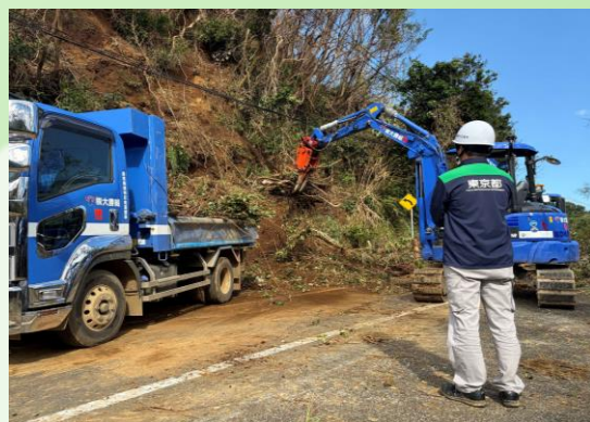
▲登龍道路にて、崩落した土砂・倒木の撤去を実施
