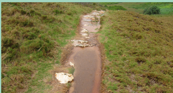
自然観察路の状態（2012年 踏み石追加工事前）
