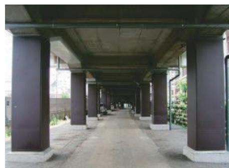
鋼板巻きによる高架橋柱耐震補強
