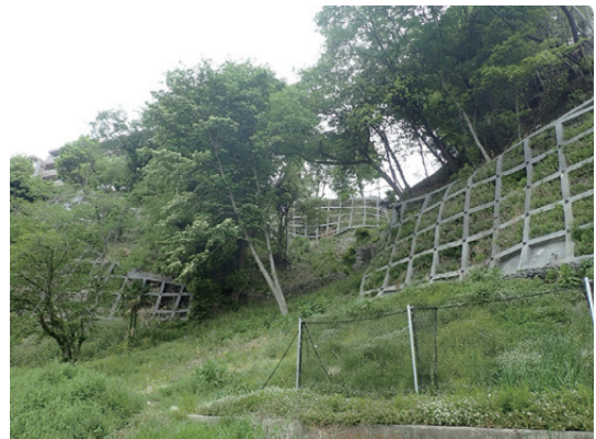
河辺町一丁目地区 急傾斜地崩壊対策事業（青梅市）
