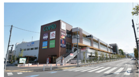
八王子市長房地区まちづくりプロジェクト 施設外観
