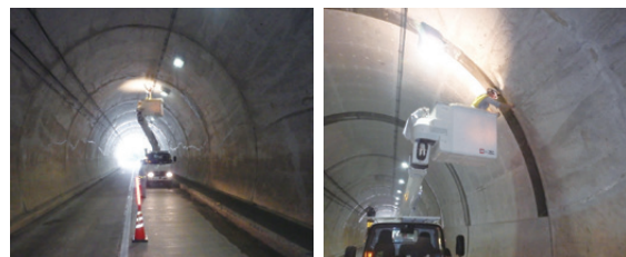
トンネルの予防保全型管理
