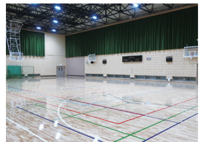
東京都多摩障害者スポーツセンター 体育館照明のLED化
