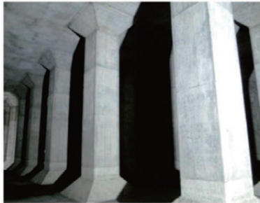
▲補強前の配水池
