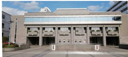
立川地域防災センター
