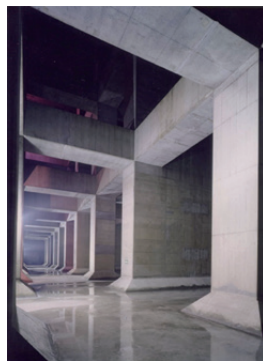
黒目川黒目橋調節池
