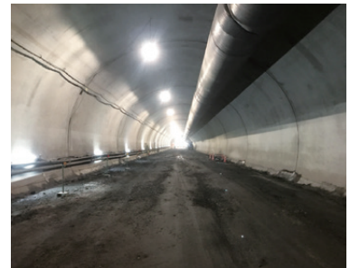
梅ヶ谷トンネルの整備状況
