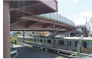
施工例（小宮陸橋（八王子市））
