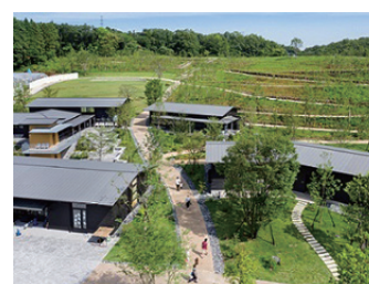
町田薬師池公園四季彩の杜西園(町田市)
