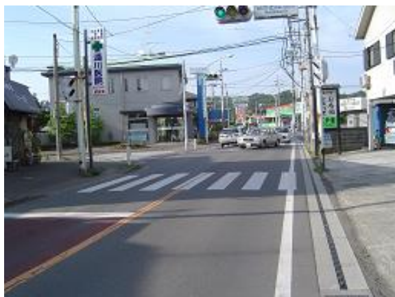
〔整備前の日の出団地前交差点〕
