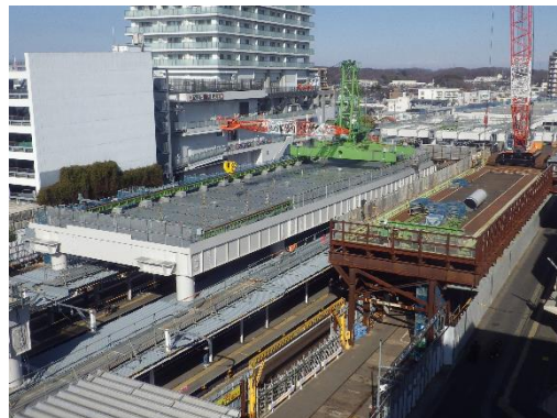
〔工事中の東村山駅〕
