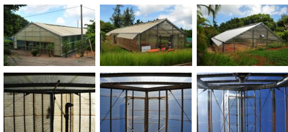
写真 1 鉄骨ハウスの外観(上)および屋根 a) (下) a) 屋根は屋内から真上(空)に向けて撮影した。
