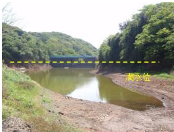
図2 玉川ダム貯水状況（12/7）
