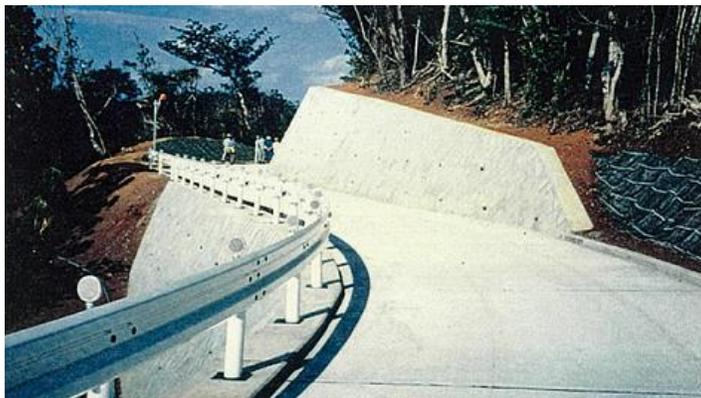
母島にはアスファルトプラントが設置されていないため、路面は全てコンクリート舗装としている。
