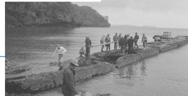
小突堤は海底部分が洗掘され危険であったため、応急復旧工事により、突堤根固め部を水中コンクリートで補強した。
