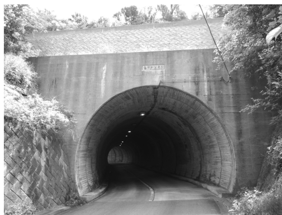
長崎トンネル
