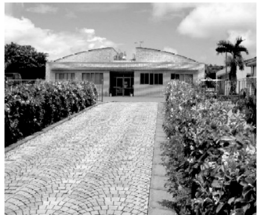
亜熱帯農業センター本館
