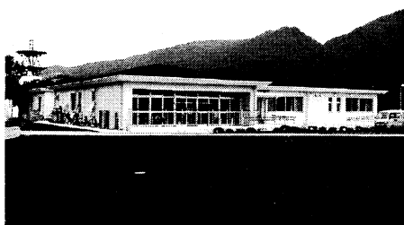
八丈島共同福祉作業所全景(中道)
